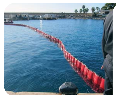
Déploiement du barrage
